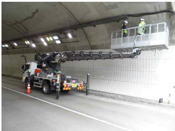
고소점검차를 이용한 근접조사
