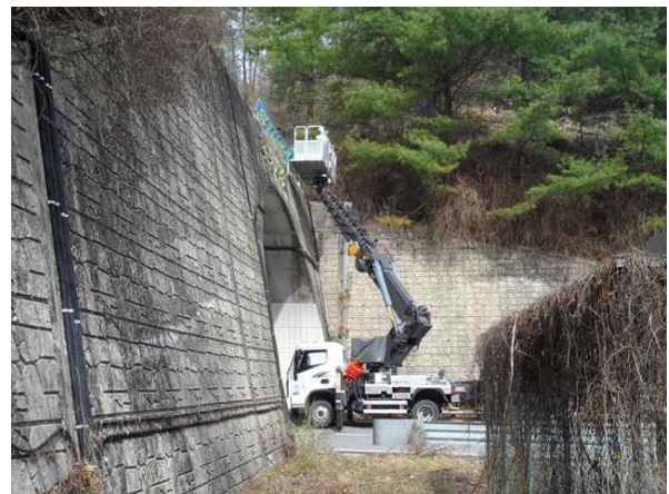
고소점검차를 이용한 근접조사
